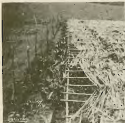
No. 4. — Almacén cubierto.
